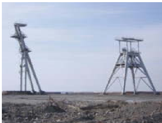
図2 有明坑立坑櫓
