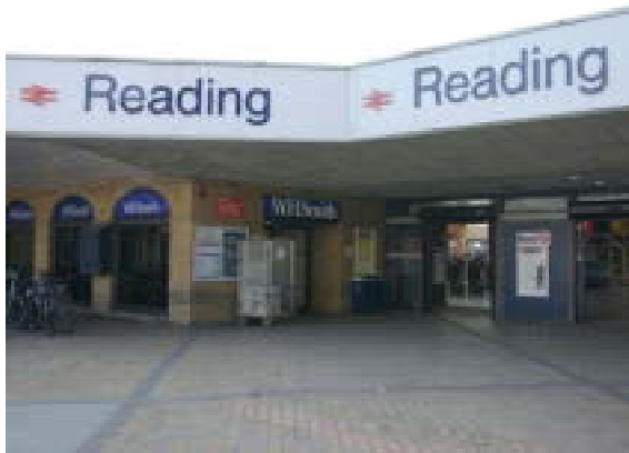
図6 現在の駅の入口
