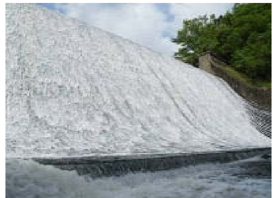
写真 3 白水ダム堰堤(竹田市)
