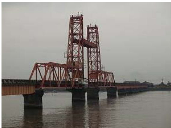
写真1. 筑後川昇開橋
