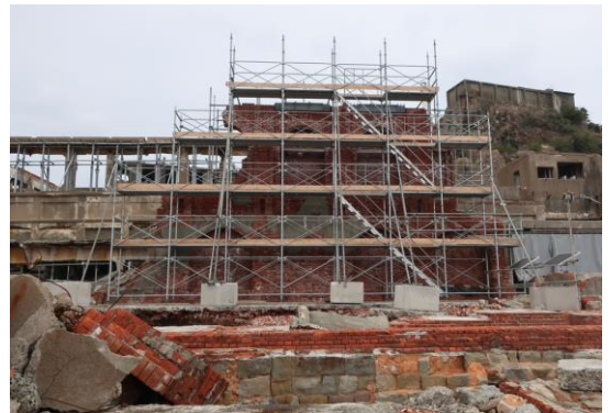
図 3 足場が組まれた建造物
