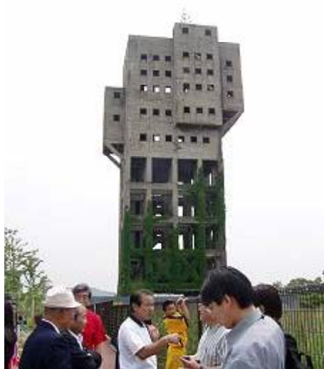
写真 1 志免炭鉱豎坑櫓
