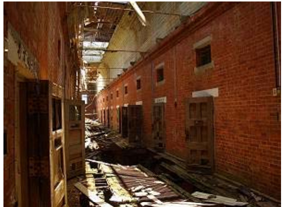
写真 今は無き長崎刑務所舎房棟
