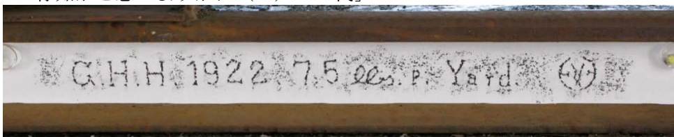
写真 1922年ドイツG.H.H.社製、九州鉄道（Ⅱ）の75ポンドASCE型レール
