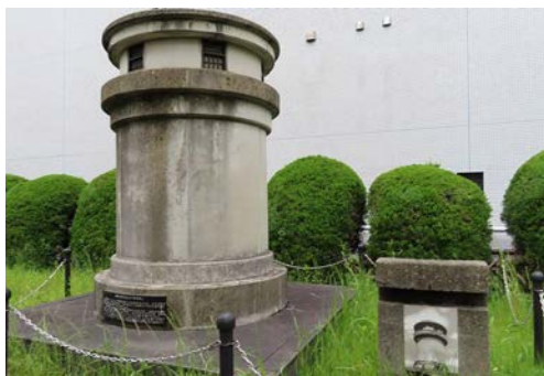
写真 給水塔（縮小レプリカ）
