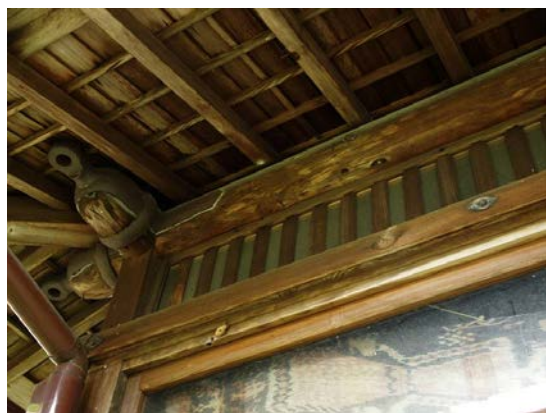
写真 軒桁に転用された帆柱 （太宰府市・定遠館）
