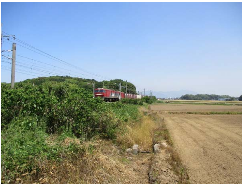
写真1:千代丸踏切付近の新旧両線接合地点
